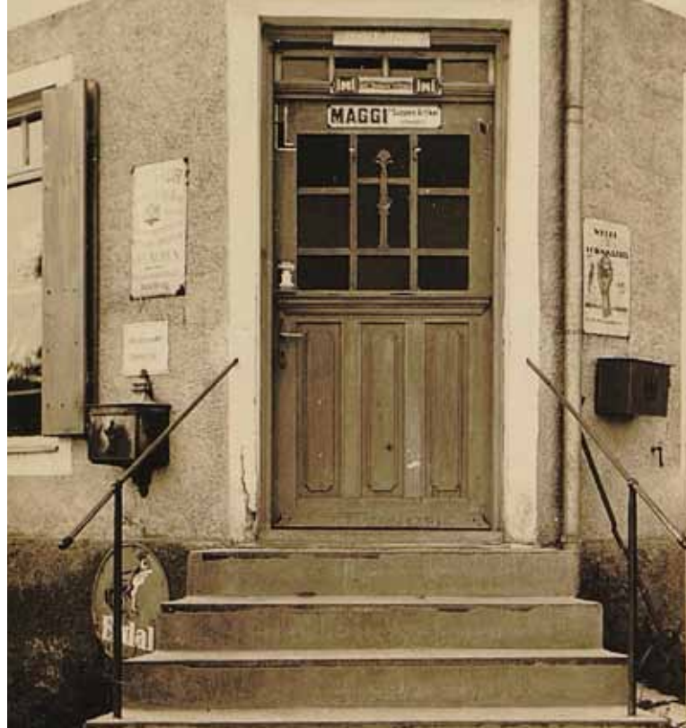
▲ Eingang des Postamts Altomünster mit dem „Vogelbrutkasten“ auf der linken und dem Ersatzbriefkasten auf der rechten Seite (Staatsarchiv Augsburg, Reichspostdirektion Augsburg, Poststationen 23).
